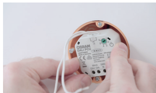
02 Legen Sie das DALI PCU in die Unterputzdose.
