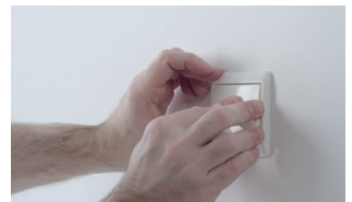
04 Montieren Sie die Abdeckung des Tasters.
