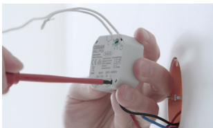
01 Verbinden Sie das DALI PCU mit den Netz- und DALI-Adern.
